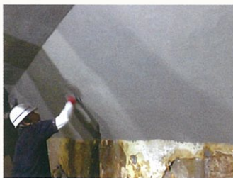
KS500 施工状況
