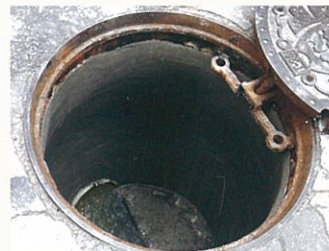
マンホール内施工完了
